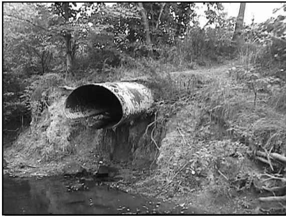
Outlet Conduit Deterioration
