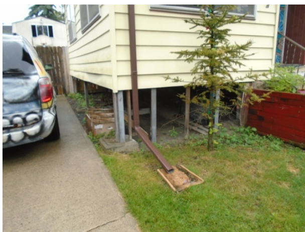
HDF-2017-5836-NEP, 510 N. Grant St., Porch Repairs BEFORE
