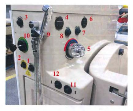
1 RINSE JETS 2 DISINFECT JETS 3 HAND SPRAYER ON/AUTO - OFF 4 FILL/SHOWER TEMPERATURE DISPLAY 5 FILL/SHOWER TEMPERATURE CONTROL (MIXING VALVE) 6 SPA TEMPERATURE DISPLAY 7 AQUA-AIRE ON/OFF 8 TUB FILL ON/OFF 9 HAND SHOWER 10 SPORICIDE PUMP
