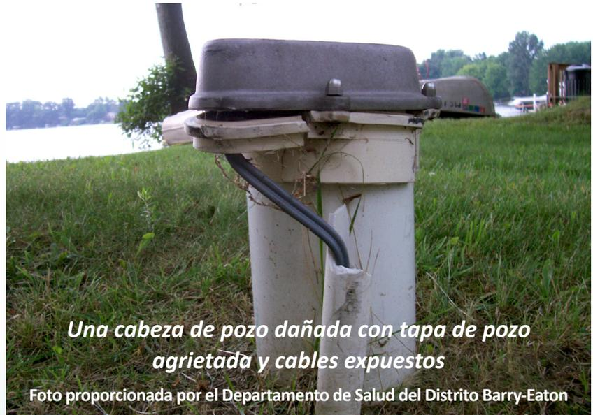
*Una cabeza de pozo dañada con tapa de pozo agrietada y cables expuestos*
