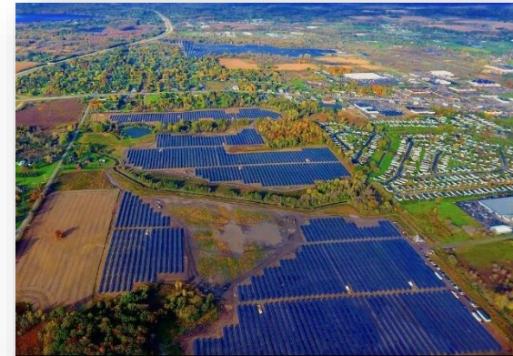
Lapeer Solar Array
