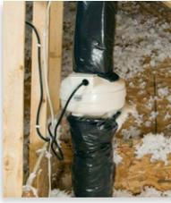
El **ventilador de radón** se encuentra en un espacio sin acondicionar, como un ático o en el exterior, para prevenir que el radón se filtre nuevamente dentro del hogar. El ventilador se enchufa en una caja de empalme o cableado eléctrico.
