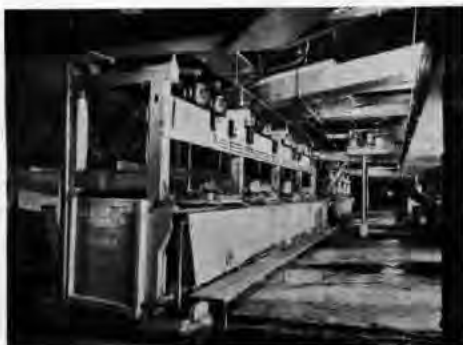
Figure 3. Fahrenwald flotation machines, Ahmeek mill.
