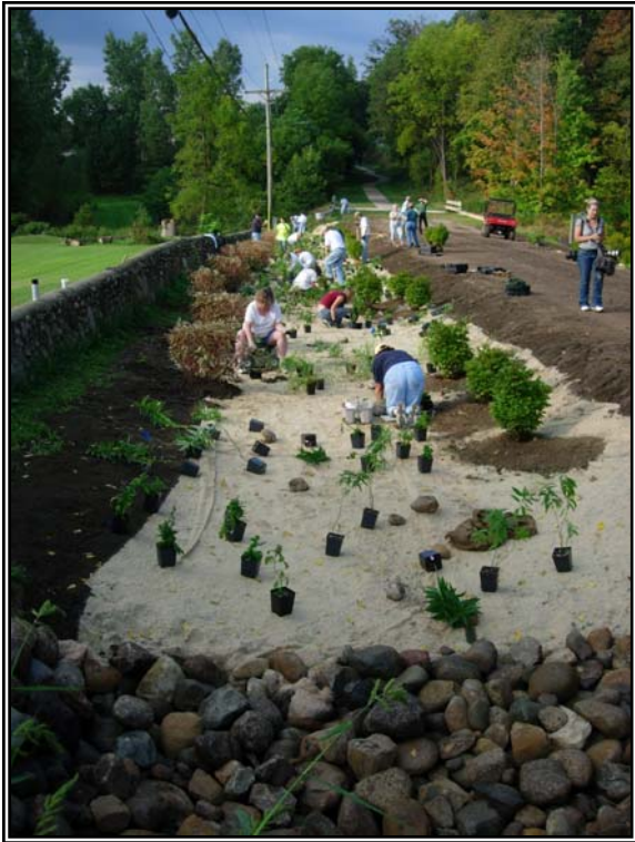
Van Hoosen West Bioswale & Riprap Spreader
