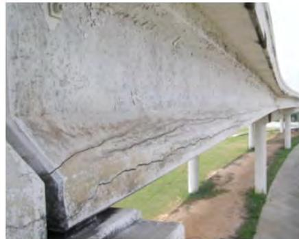
(d) Wide longitudinal cracking
