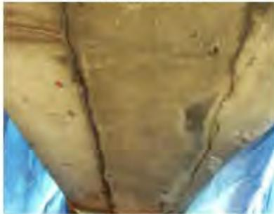
(d) Wide longitudinal cracking
