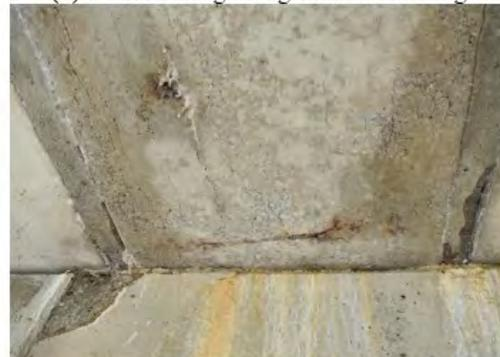
(d) Bottom flange random cracking
