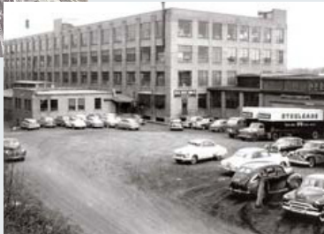
(Kulia) Metal Office Furniture Co. kabla ya 1954
