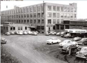
(Kulia) Metal Office Furniture Co. kabla ya 1954
